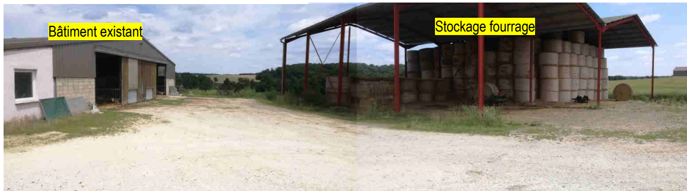
Stockage paille et bâtiment existant
