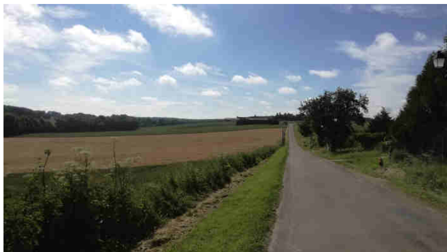
1. Vue de la route communale à la sortie de Perreux en direction des Girande
